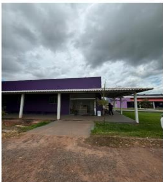
AMPLIAÇÃO DO HOSPITAL VETERINÁRIO DE PEQUENOS ANIMAIS
